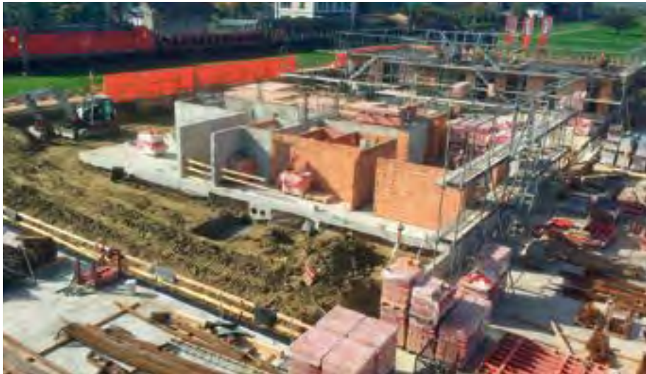
Trotz tiefer Verstossquote werden Kontrollen über die Lohn- und Arbeitsbedingungen am häufigsten auf Baustellen durchgeführt.
